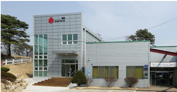
[사무동] 품질보증팀, 생산팀, 생산관리팀, 인사총부팀 사무실 및 회의실
